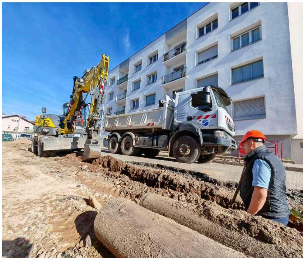
Après les réseaux humides, ce sont les réseaux secs qui sont enterrés rue de la Ménantille.
