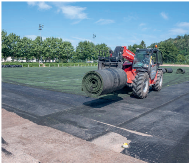
Les travaux ont démarré à la mi-juillet.
