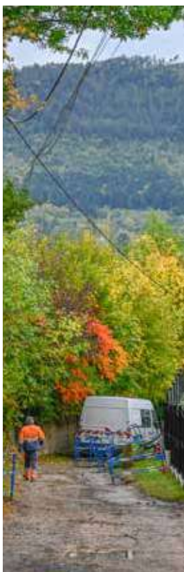
Le chemin des Bouquets est en travaux.
