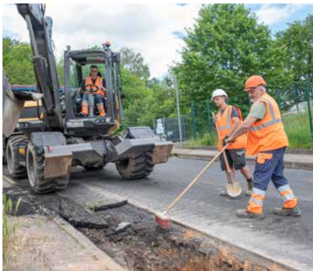
La mise en sens unique permet d'effectuer des travaux dans la rue.
