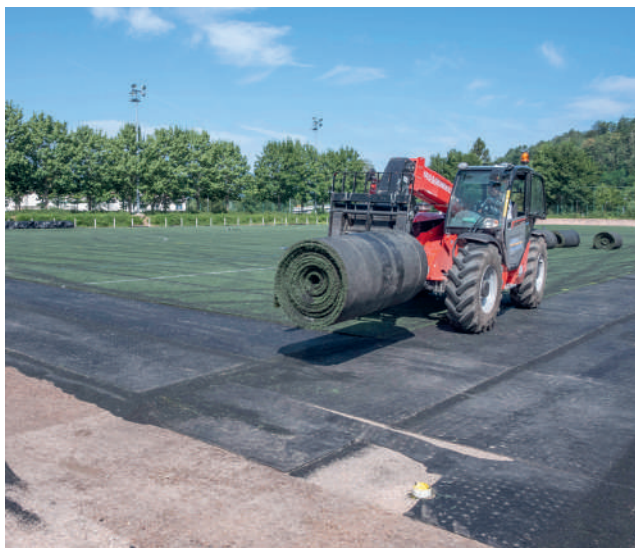
Les travaux ont démarré à la mi-juillet.
