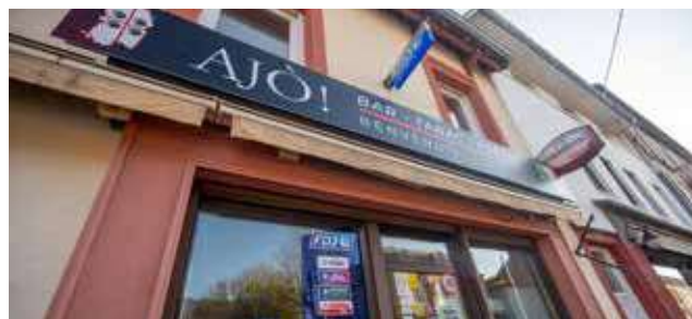
La façade du bar-tabac de la Bolle a été refaite par Stéphanie Luciano.
