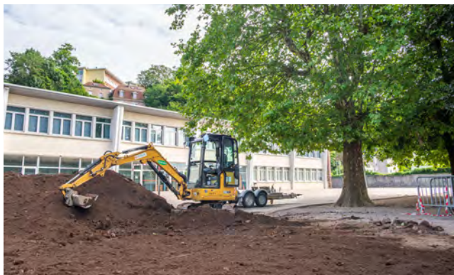
Les travaux ont commencé en juillet.
