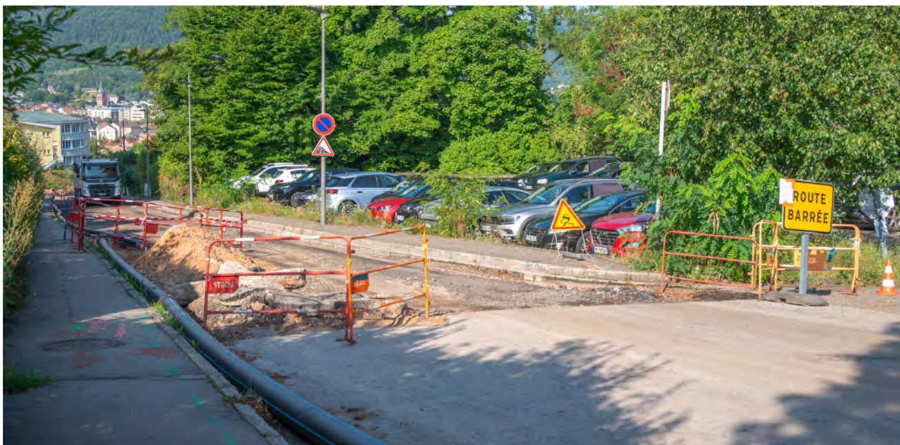
Les travaux sur le réseau humide de la rue du Nouvel-Hôpital sont terminés.
