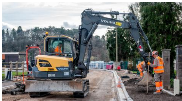
L'avenue Jean-Prouvé était en travaux ces derniers mois.
