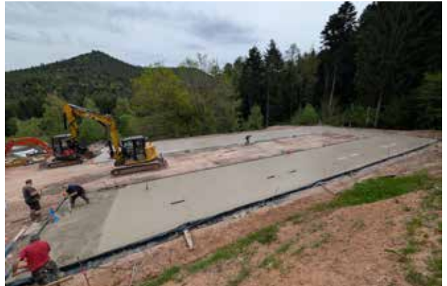
La dalle béton a été réalisée en avril et les premiers box ont été livrés courant juin.
