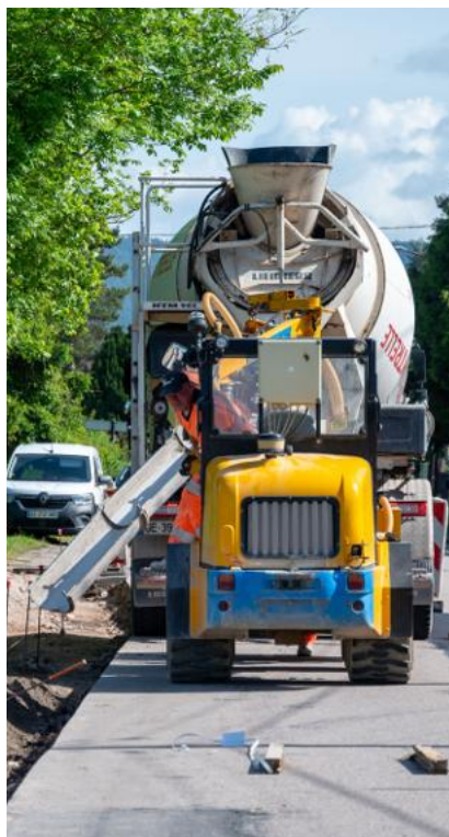
Les engins de chantier seront prochainement dans la rue des Genêts.
